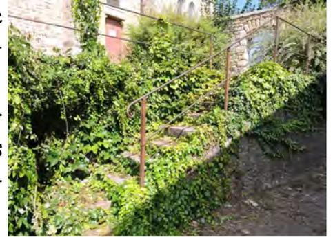
La prestation a consisté à la fabrication et la pose d'une rampe, avec barreaudage vertical en fer rond, sablage, métallisation et thermo laquage, sur une longueur totale de 59 mètres.
