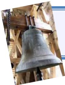
Après être monté au clocher par un escalier en colimaçon bâti dans le petit clocheton, on découvre **deux** cloches, électrifiées en volées et tintements, montées sur beffroi bois. Ce sont ces deux cloches qui rythment la vie de notre village (heures, demi-heures, angélus, glas, carillons...), et auxquelles les Tramblyrons sont habitués et bien attachés.
